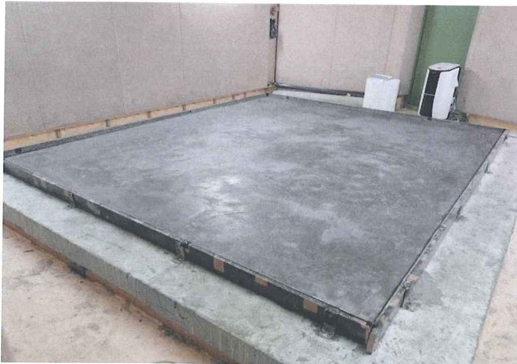
圖6.4 試件施工完成
