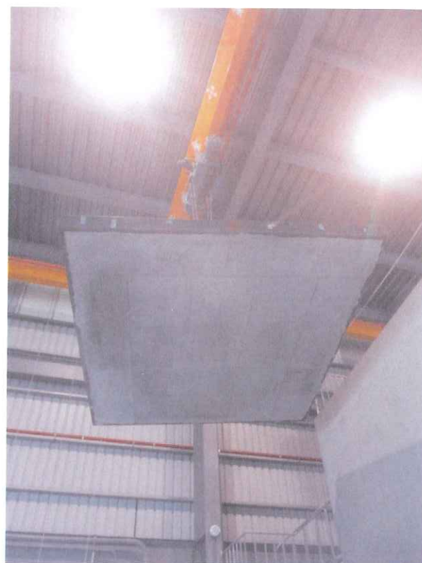
照片 6 試驗件施工完成背面
