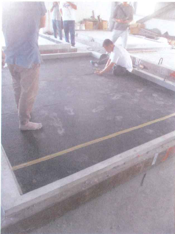
照片 3 試驗件組裝過程(隔音墊鋪設)
