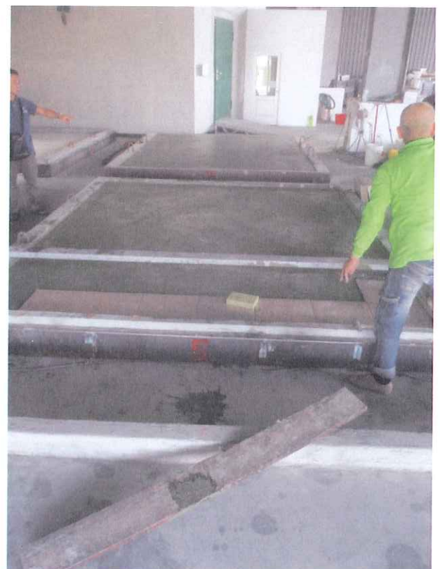
照片 4 試驗件組裝過程(地磚鋪設)
